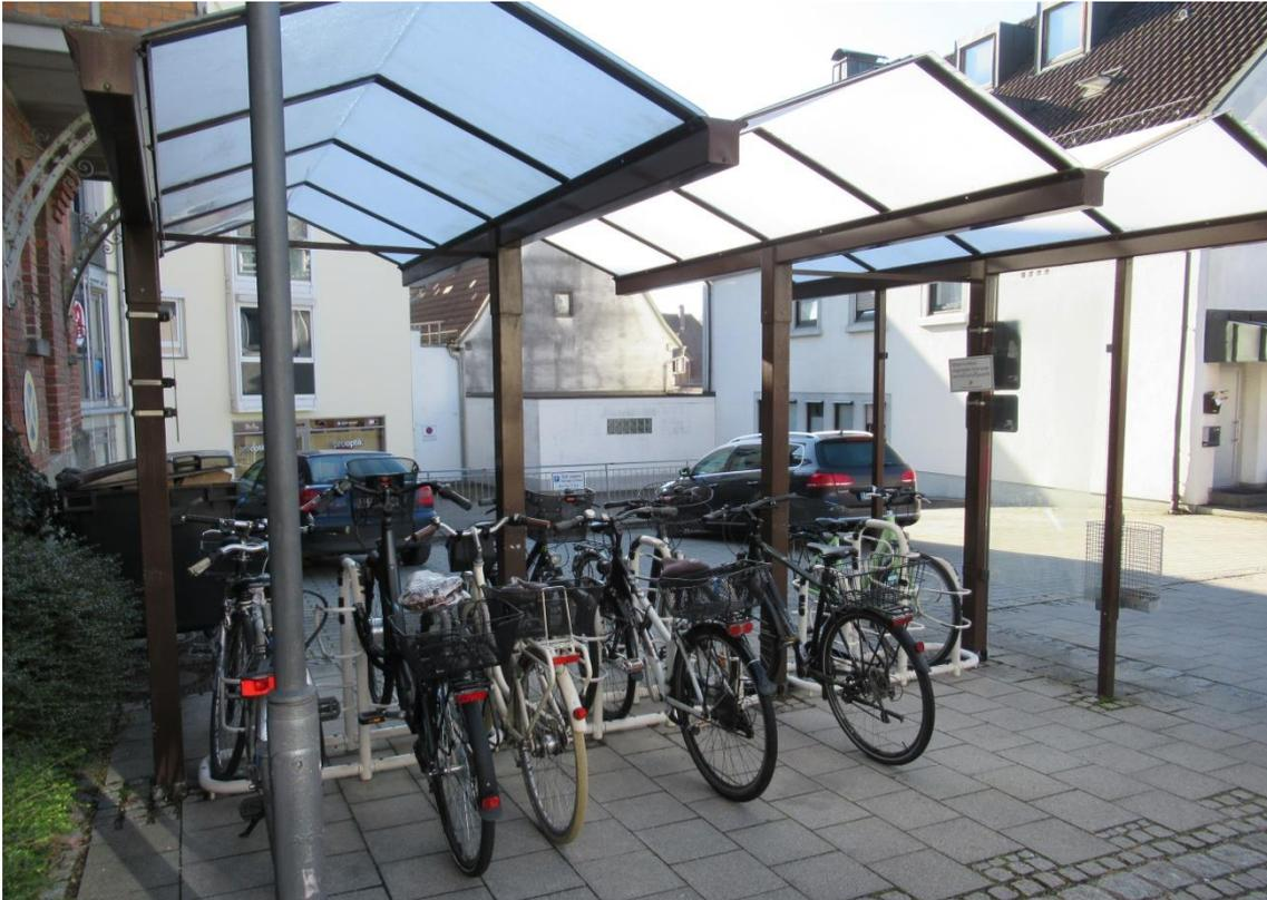
**Abbildung 2-3: überdachte Abstellanlage mit kombiniertem Vorderrad- und Anlehnhalter**
